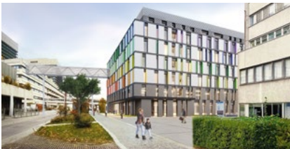
Das neue Zentrum bietet vier Operationssäle für Kinder.
